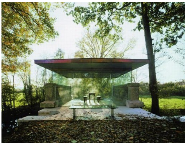
Рисунок 2. Храм любви II в Бургундии (Франция) использует стеклянные пластины минимальной толщины, чтобы выдерживать сжимающие нагрузки крыши, создавая полную панораму.
